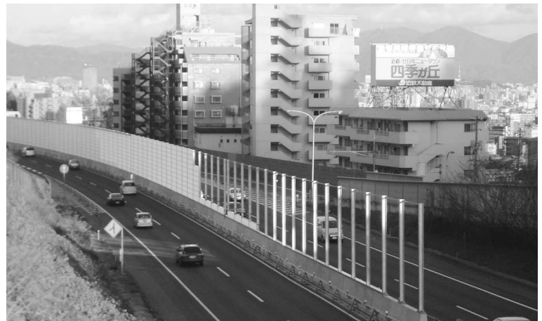
西広島バイパス遮音壁（田方陸橋から広島方面を臨む）
