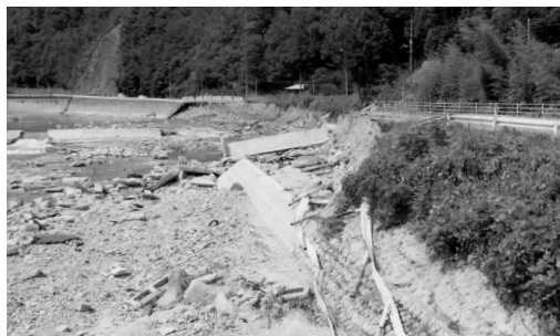
国道433号線の道路・河川(水内川)が崩壊 頭首工の崩壊も見える(写真中央) (湯来町大字麦谷 大出橋付近)
